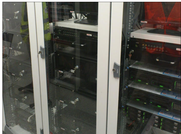
jednotlivé video-analyzátoři v rozvaděči
